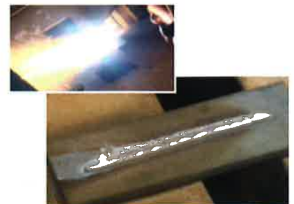
エアプラズマ ガウジング 施工例
